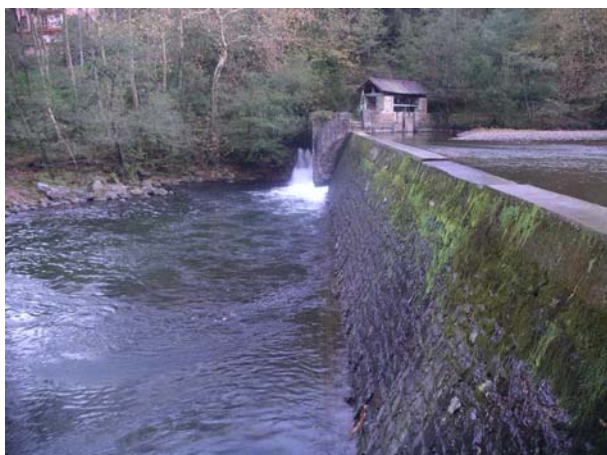
Foto 1. Azud y toma del canal en margen derecha.
