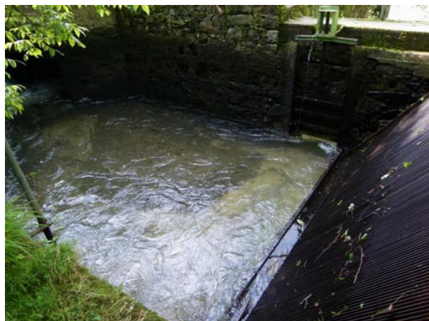
Foto 4. Rejilla y aliviadero de fondo.
